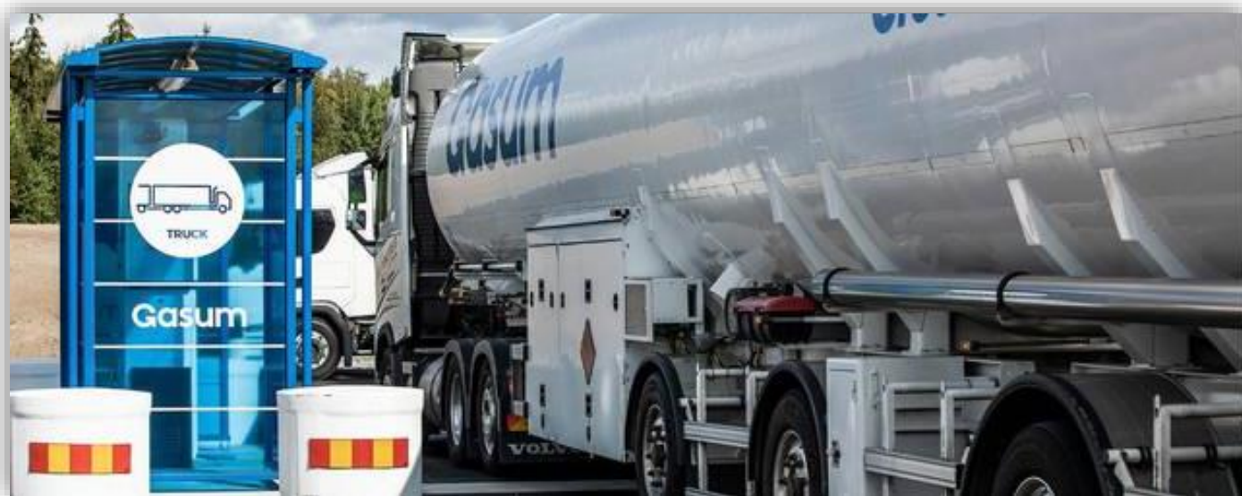
Ny tankstation i Jönköping för tunga gasfordon.
