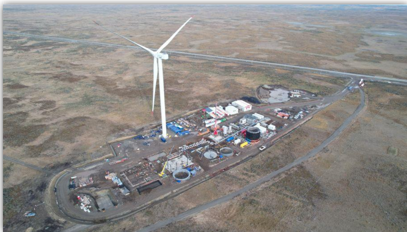
Highly Innovative Fuels testanläggning är under uppbyggnad i södra Chile.
